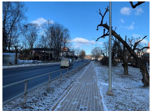
3-18. ATTĒLS. ATMODAS IELA JEB VALSTS REĢIONĀLĀ AUTOCEĻĀ P27 VIRZIENS
